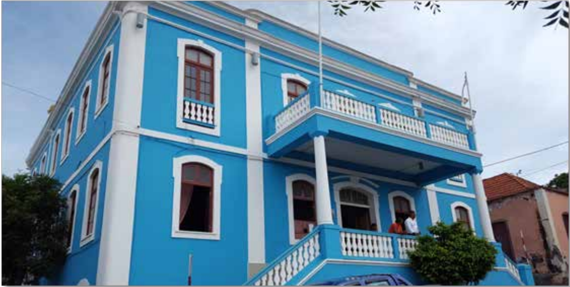
Ilustración 8-. Sede de la Câmara Municipal de São Filipe
